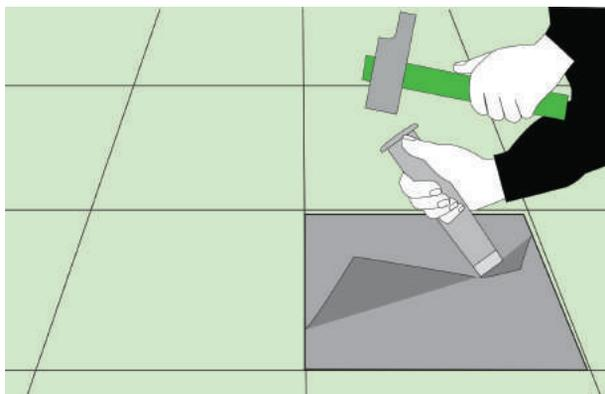
Следует удалить слой клея вплоть до стяжки.
